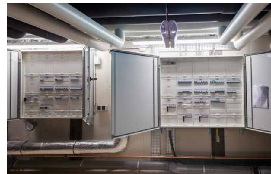
De afgelopen jaren heeft Hager een significante bijdrage mogen leveren aan de vernieuwing van de elektrotechnische installatie in WTC Rotterdam.
