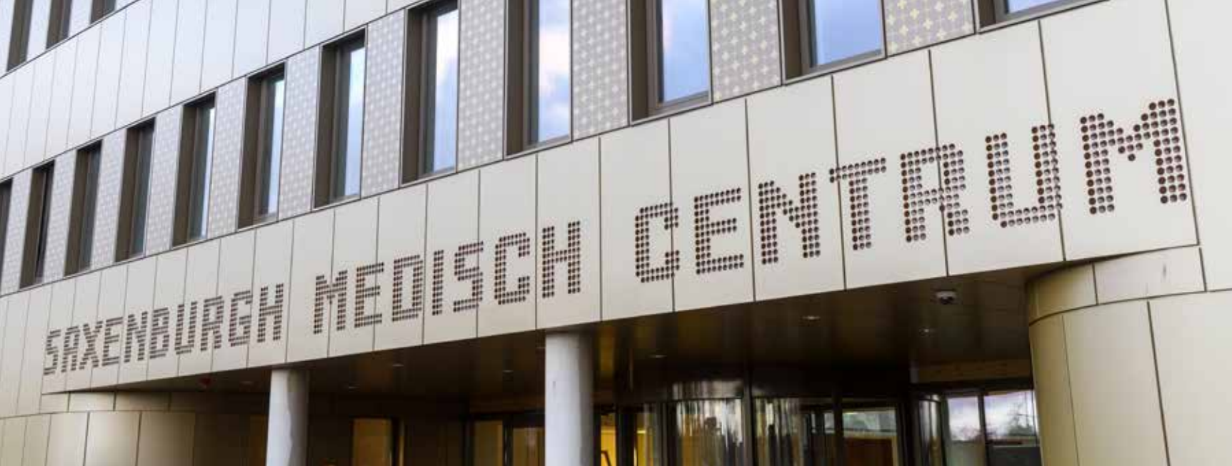
Eind maart is in Hardenberg het Saxenburgh Medisch Centrum opgeleverd. (Beeld: Anton van Daal / HOMIJ Technische Installaties).
