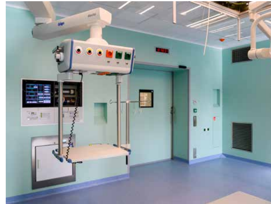
Mocht onverhoopt de netspanning in het Saxenburgh Medisch Centrum uitvallen, dat zorgt de PLC-besturing van Hager dat de noodstroomaggregaat binnen 15 seconden opstart en dat alle cruciale installaties onder spanning blijven. (Beeld: Anton van Daal / HOMIJ Technische Installaties).
