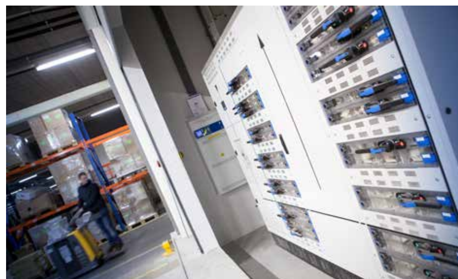
Aan de hoofdverdeler, subhoofdverdeler en onderverdelers werden specifieke eisen gesteld. "Denk bijvoorbeeld aan de afmetingen, kortsluitstromen en beschermingsgraad (IP-klasse).
