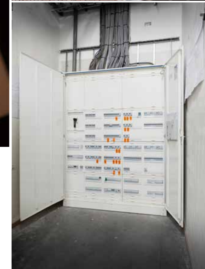
Na akkoord door Heijmans heeft Hager de hoofdverdeler en onderverdelers (met geïntegreerde KNX-componenten) gebouwd.
