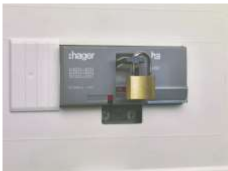
S014, hangslot voor draaischakelaar
