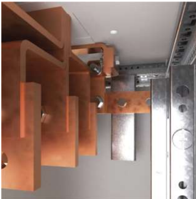
PE-aansluiting
