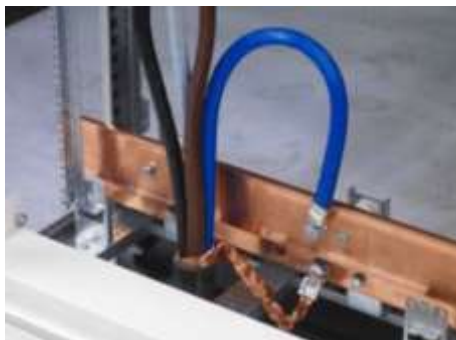
Aansluiting op UST42PEN
