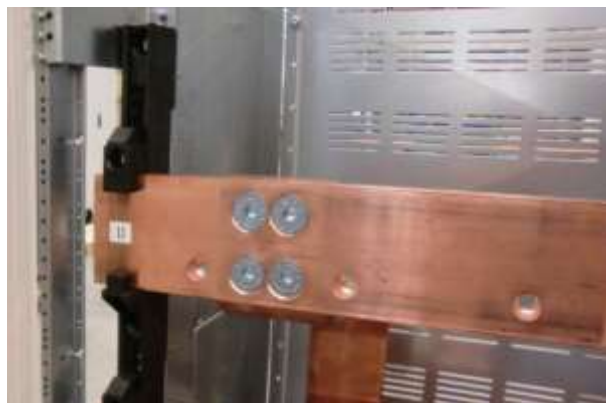
Invoer 185 mm railsysteem
