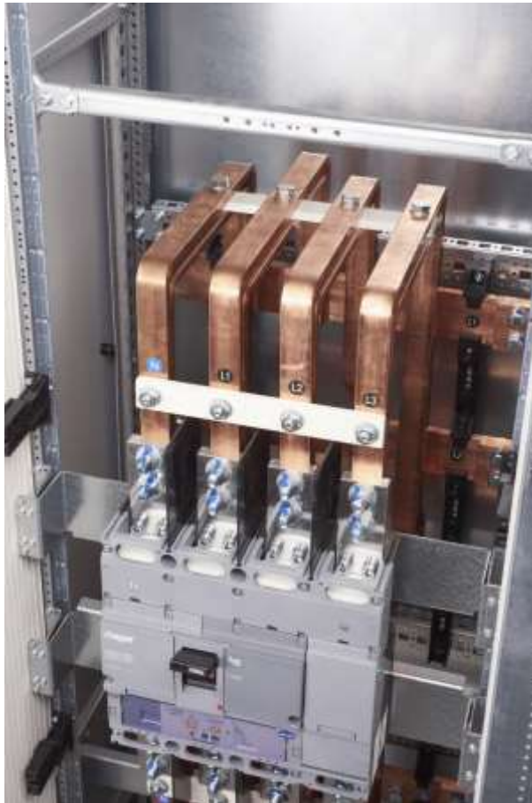
Aansluiting boven, 1000 A
