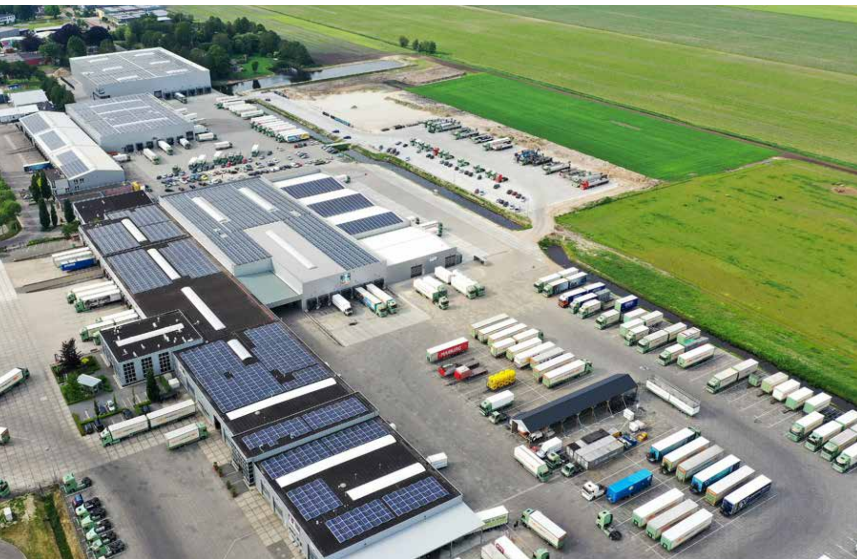
In verschillende fases zijn alle gebouwdaken van Oegema Transport Dedemsvaart BV voorzien van zonnepanelen.
