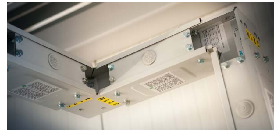
Boskalis gebouw 6 in aanbouw.
