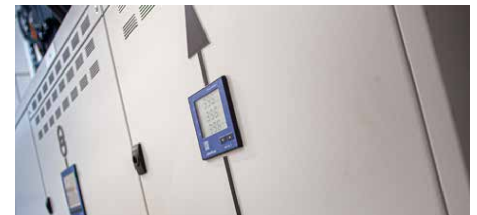
De hoofdverdeler betreft een Hager IP40 Weber Unimes systeem van 3.200 Ampère.
