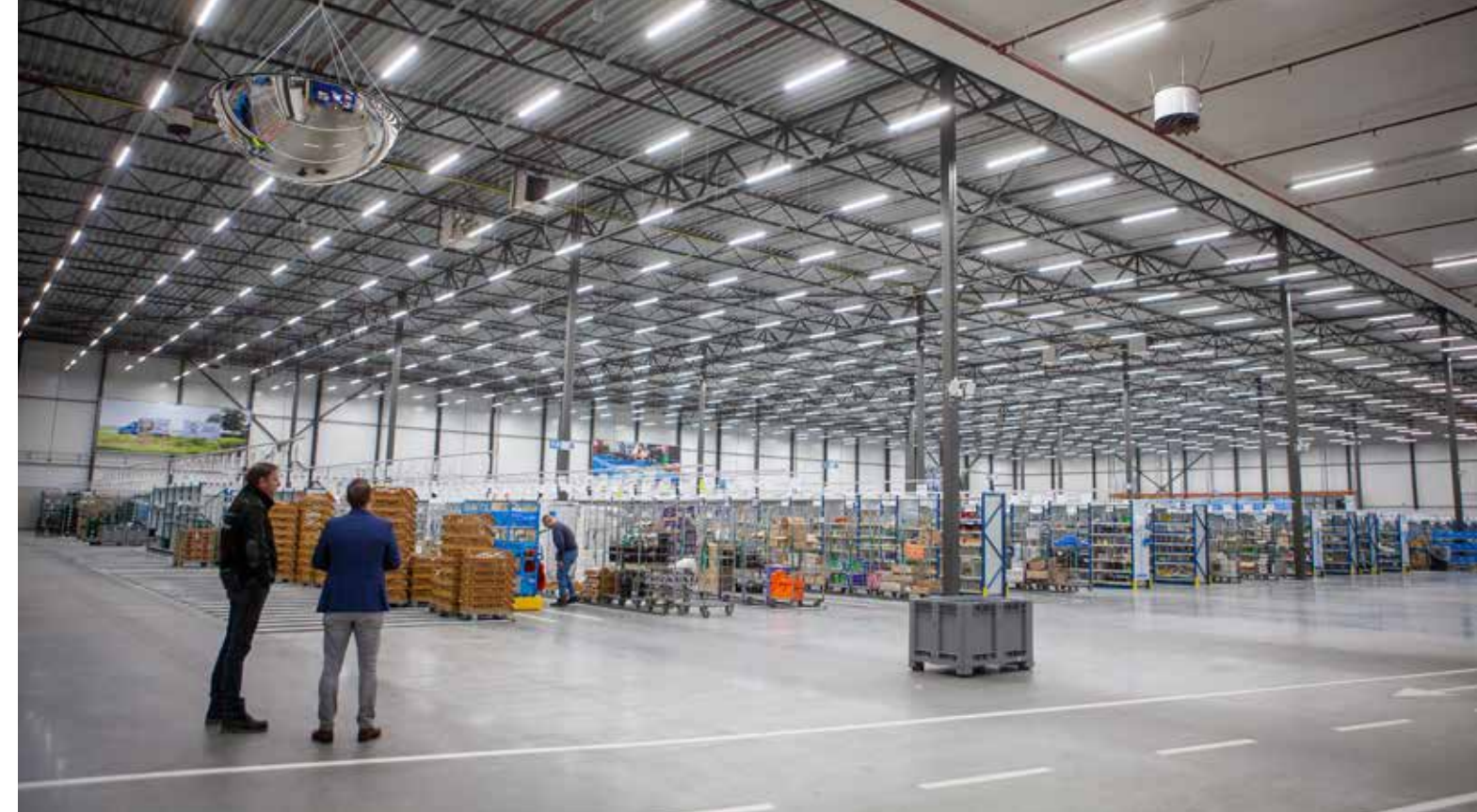
Het nieuwe distributiecentrum is gevestigd in een bestaand logistiek gebouw, dat voor zijn nieuwe functie grondig is verbouwd.
