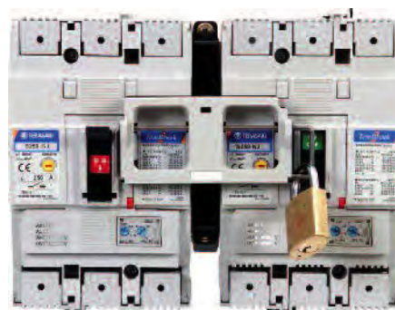
Slidevergrendeling tussen twee vermogensautomaten
