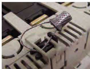
Afschermkap voor aansluitklemmen met verzegeling
