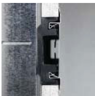
Double plaque de plâtre : dépasse de 3 mm
