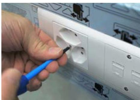
Fixation du disque central et du cache avant de terminer le travail en retirant le film de protection.
