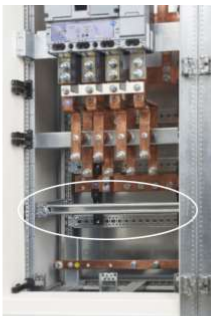
Kabelabfangschiene (Kabel nicht dargestellt)
