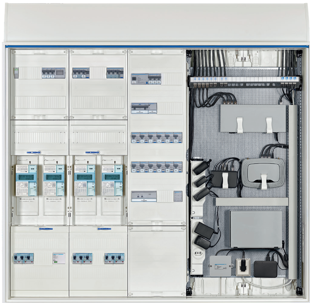
Technikzentrale mit Multimediafeld
