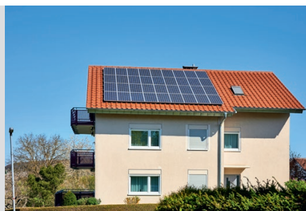
Anwendung: Energieintensives Einfamilienhaus
