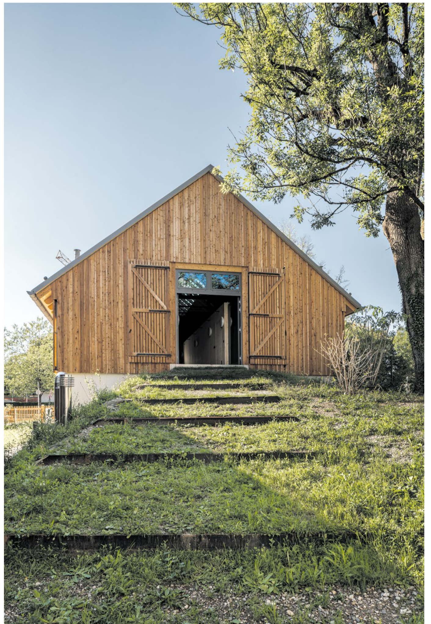
Über die Rampe des ehemaligen Heustadels wurde früher Heu eingefahren. Heute ist sie der Zugang zu vier Wohnungen.
