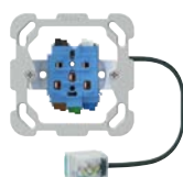
Apparat ohne Front mit Flachkabeladapter Woertz Power
