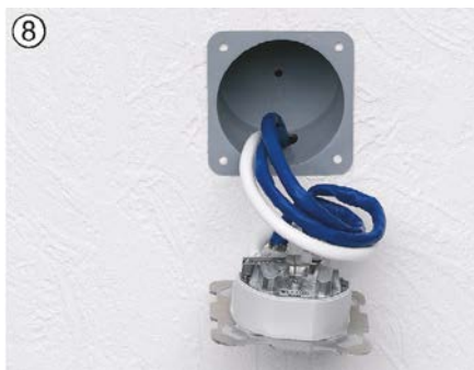
8 Kabelreserve eindrehen und Dose einbauen.
