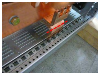
Anschlusswinkel beschneiden
