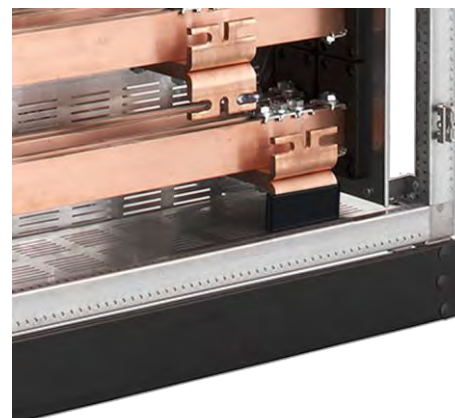
Isolierkappe 773-221-xxx auf Anschlusswinkel
