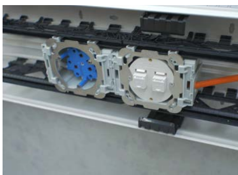
Schraublose Befestigung von Steck-/Datendosen
