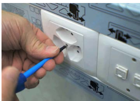
Befestigung der Zentralscheibe und Blende, bevor ganz zum Schluss die Schutzfolie entfernt wird.
