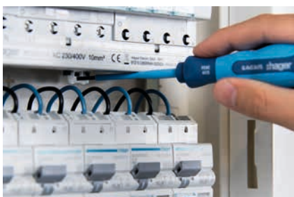
Lösen der Produkte aus Verbund mit Quick-Snap Schieber
